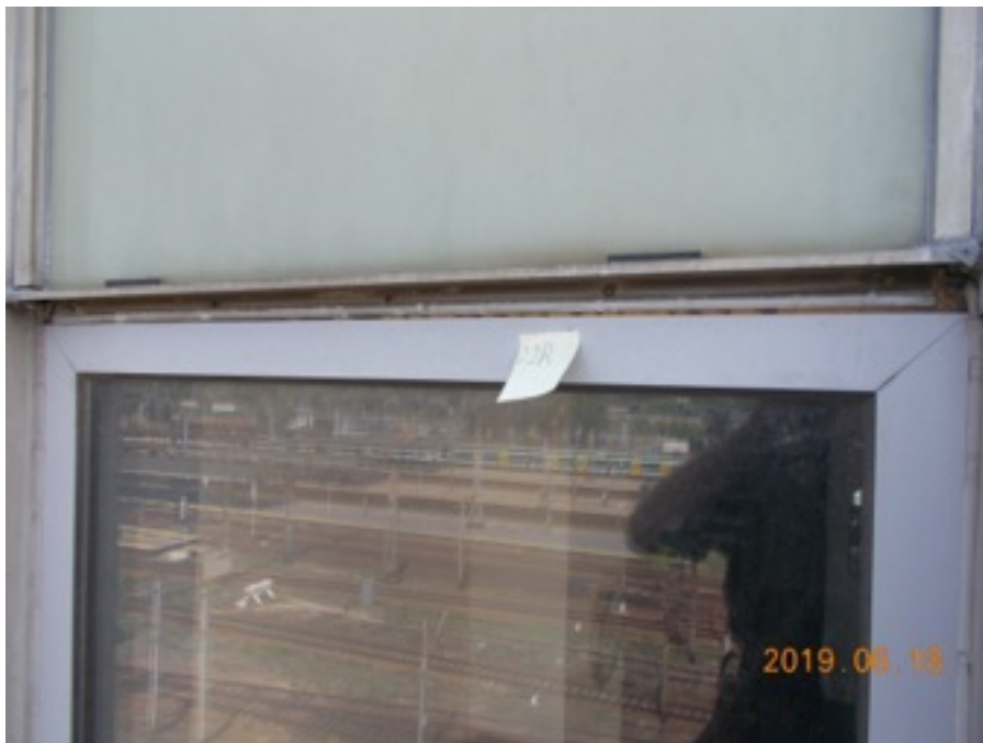
Zdjęcie Nr 107 - brak łączników w listwie fasadowej; listwa podpierająca szybę zablokowana wkrętem - IV p.
