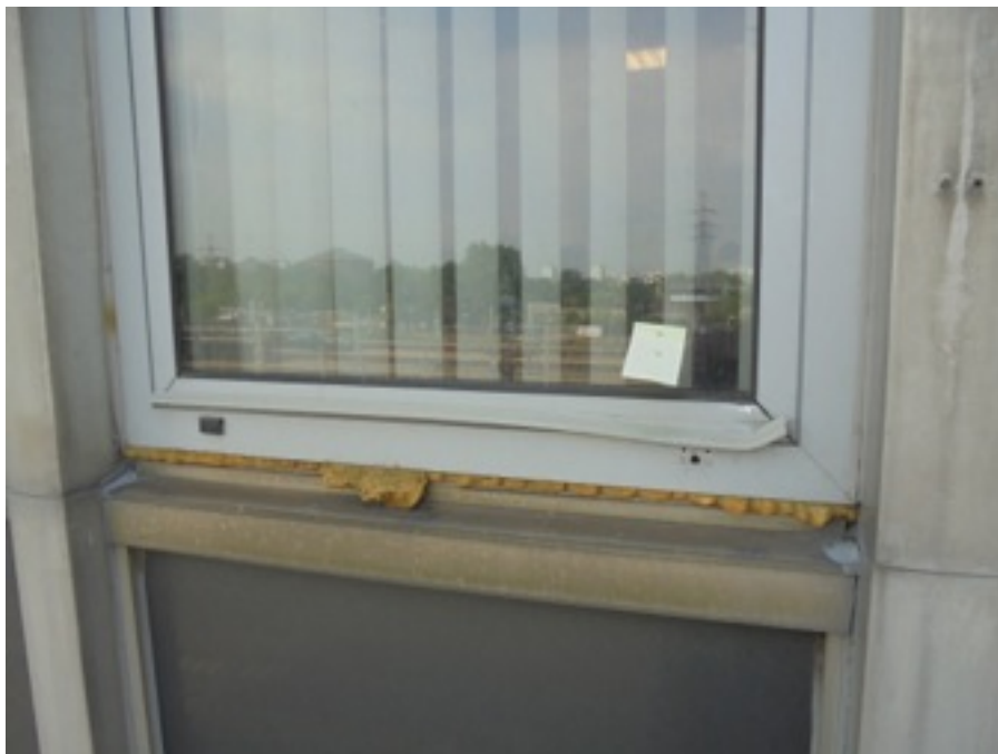
Zdjęcie Nr 51, 52, 53 - brak łączników w listwie fasadowej; listwa wspiera się na wkręcie przymocowanym do słupa fasady; brak systemowych obróbek po wymianie okna; uszkodzony okapnik w skrzydle okiennym - III p.
