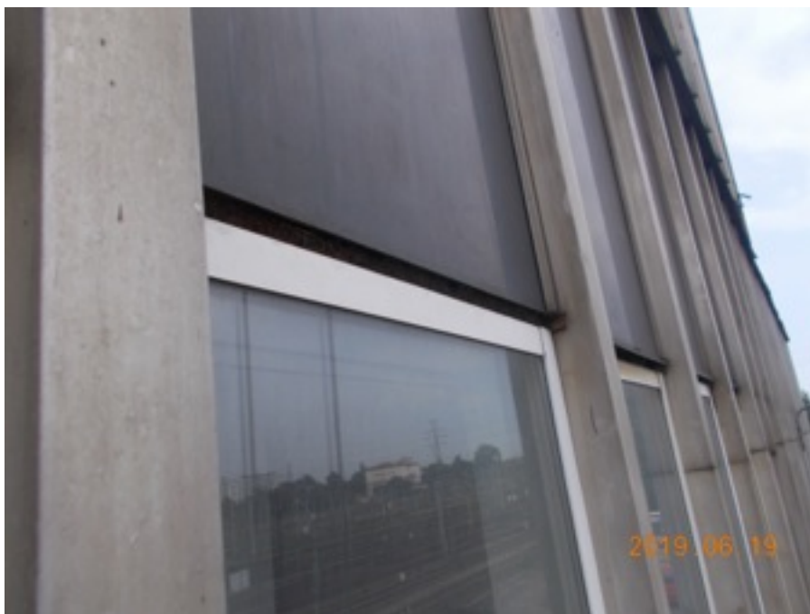
Zdjęcie Nr 143 - brak profilu podpierającego szybę nieprzezierną, brak systemowych obróbek blacharskich - I p.
