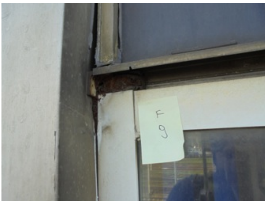
Zdjęcie Nr 54, 55 - brak łączników w listwie fasadowej; listwa podpierająca szybę wklejona na piankę montażową - I p.
