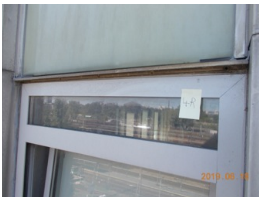
Zdjęcie Nr 67, 68 - brak łączników w listwie fasadowej; listwa podpierająca szybę zablokowana wkrętem - III p.
