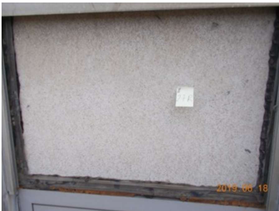
Zdjęcie Nr 114 - brak szyby nieprzeziernej, nie ma resztek szkła, prawdopodobnie wysunęła się - VI p.
