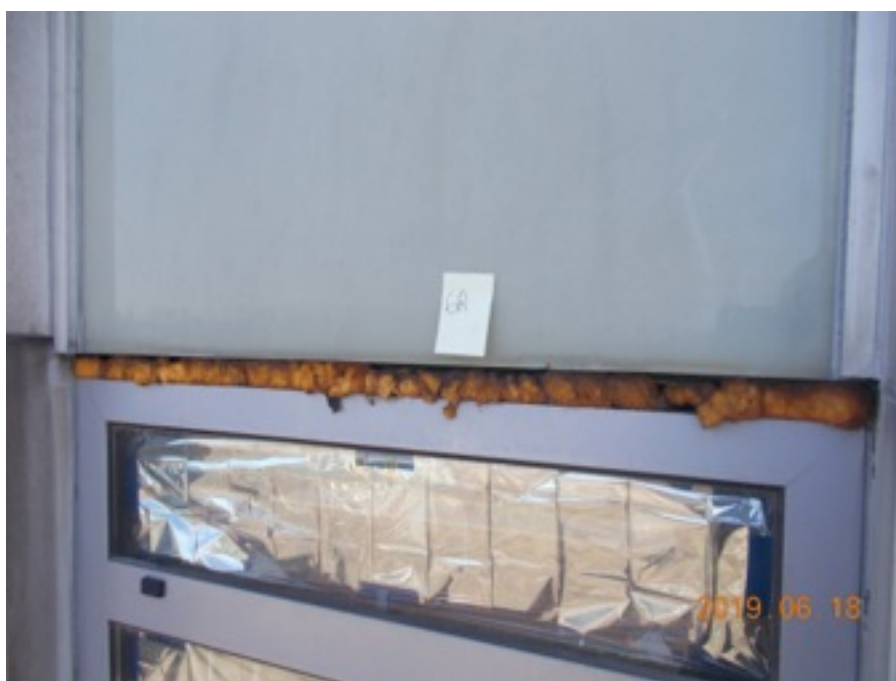
Zdjęcie Nr 73, 74, 75 - brak podparcia szyby nieprzeźiernej, dyslokacja profilu podpierającego szybę, wkręt blokujący profil poluzowany, brak ciągłości fugi - VII p.
