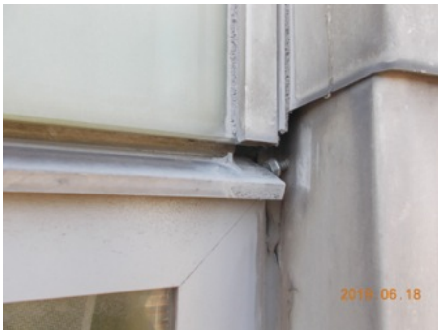
Zdjęcie Nr 73, 74, 75 - brak podparcia szyby nieprzeźiernej, dyslokacja profilu podpierającego szybę, wkręt blokujący profil poluzowany, brak ciągłości fugi - VII p.
