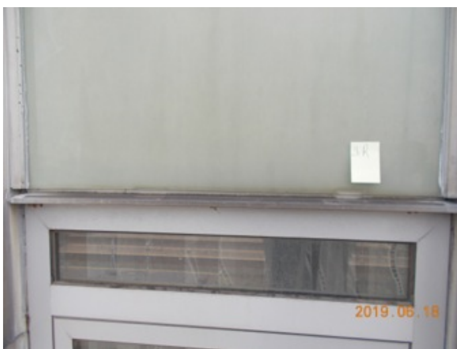
Zdjęcie Nr 112, 113 - brak podkładek gumowych do podparcia szyby nieprzeziernej - VII p.
