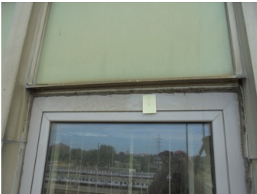
Zdjęcie Nr 34, 35 - brak łączników w listwie fasadowej; listwa wygląda na przyklejoną - IIIp.
