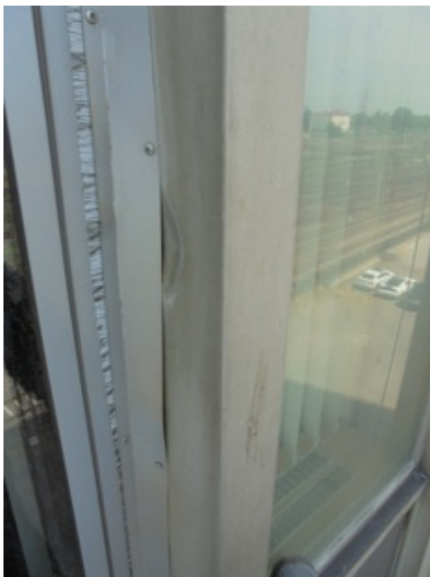
Zdjęcie Nr 27 - odkształcona maskownica na słupie, niesystemowa obróbka blacharska, resztki taśmy zabezpieczającej - III p.
