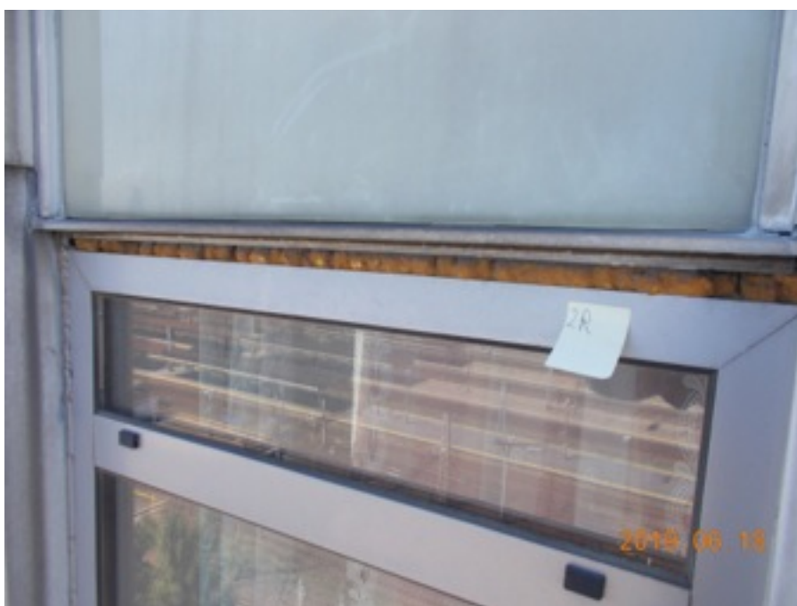
Zdjęcie Nr 63 - sposób podparcia szyby nieprzeźiernej na gumowych podkładkach jest charakterystyczny dla przeglądanej elewacji i wygląda na to, że zastosowano taki montaż w trakcie budowy budynku - VIII p.
