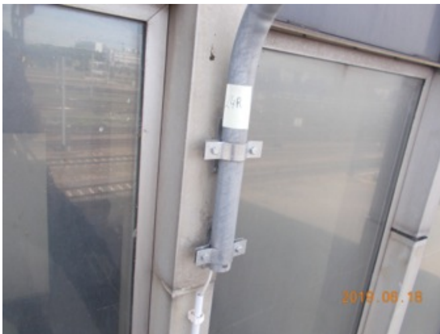
Zdjęcie Nr 110 - lampa przymocowana do maskownicy słupa! rusza się - I p.
