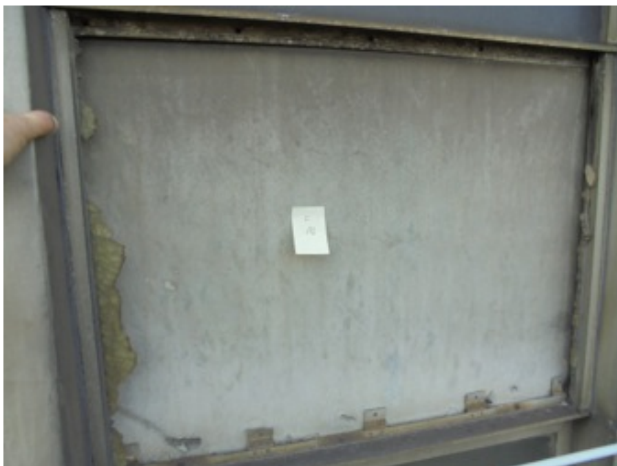
Zdjęcie Nr 56, 57 - brak łączników w listwie fasadowej; listwa podpierająca szybę wklejona na piankę montażową - I p.
