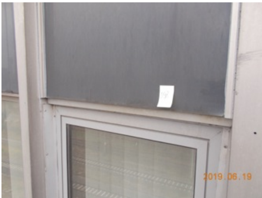
Zdjęcie Nr 132 - brak listwy podpierającej szybę nieprzezierną - III p.
