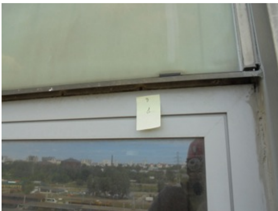
Zdjęcie Nr 27 - odkształcona maskownica na słupie, niesystemowa obróbka blacharska, resztki taśmy zabezpieczającej - III p.
