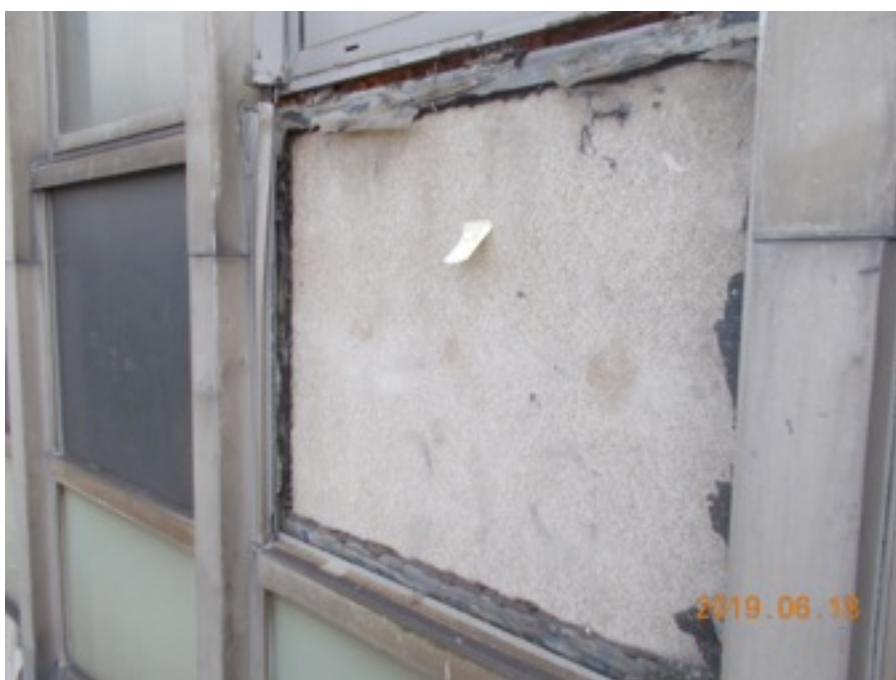
Zdjęcie Nr 120 - brak listwy podpierającej szybę nieprzezierną; szyba z prawej strony wysuwa się z profilu mocującego. - III p.
