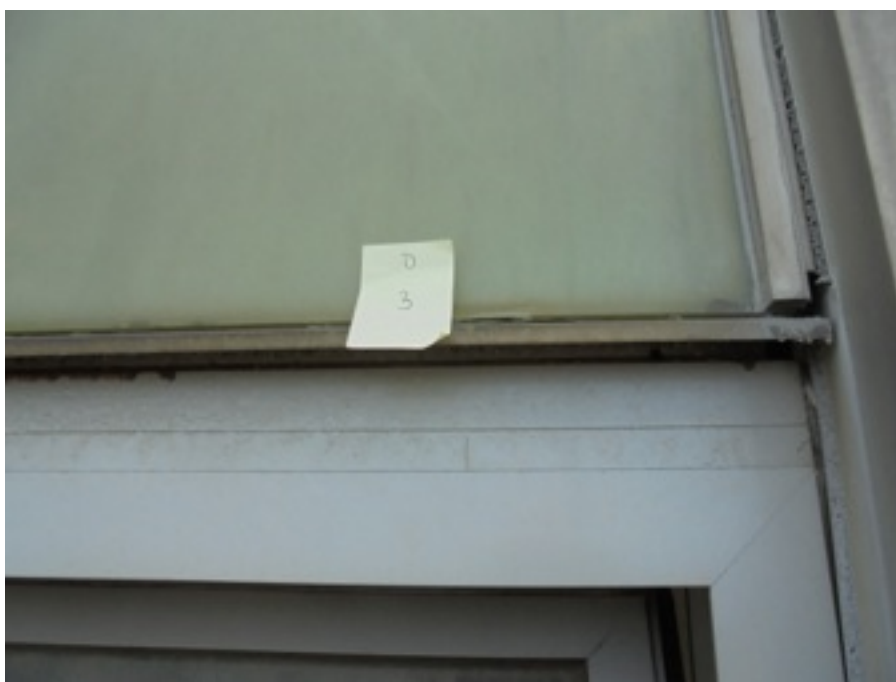
Zdjęcie Nr 30, 31 - brak łączników w listwie fasadowej; listwa wygląda na przyklejoną - VIIp.
