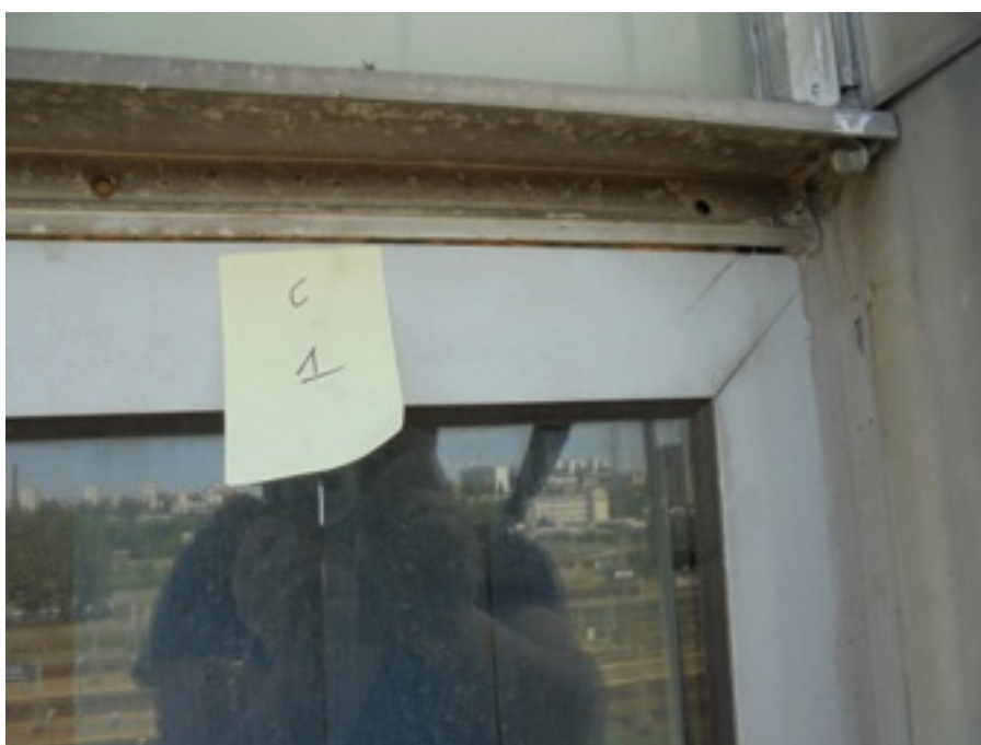
Zdjęcie Nr 11 - niesystemowe obróbki po wymianie okna; szyba nieprzezierna bez podparcia i mocowania dolnego poziomego, przyklejona do pionowych listew fasadowych - III p.
