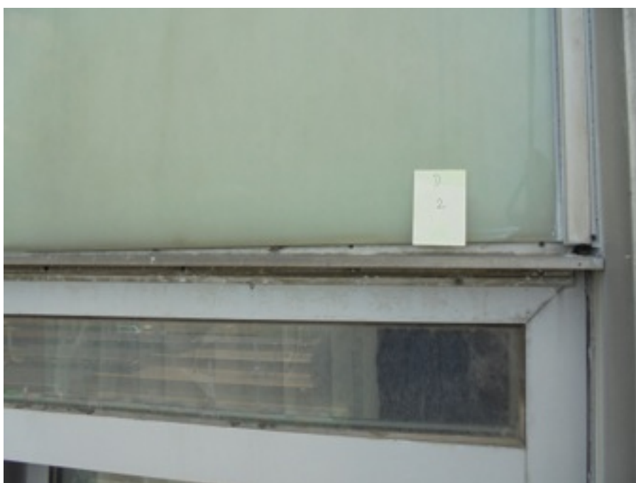
Zdjęcie Nr 28, 29 - brak łączników w listwie fasadowej; listwa wygląda na przyklejoną - VIII p.
