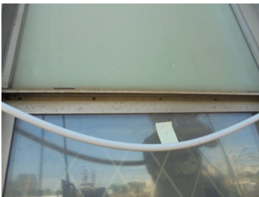
Zdjęcie Nr 3 i 4 - brak łączników w listwie podpierającej szybę w pasie szklenia nieprzeziernego - 0 p.
