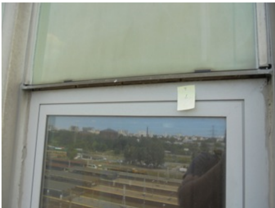
Zdjęcie Nr 28, 29 - brak łączników w listwie fasadowej; listwa wygląda na przyklejoną - VIII p.
