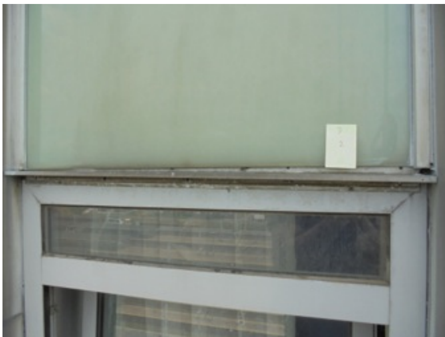
Zdjęcie Nr 30, 31 - brak łączników w listwie fasadowej; listwa wygląda na przyklejoną - VIIp.
