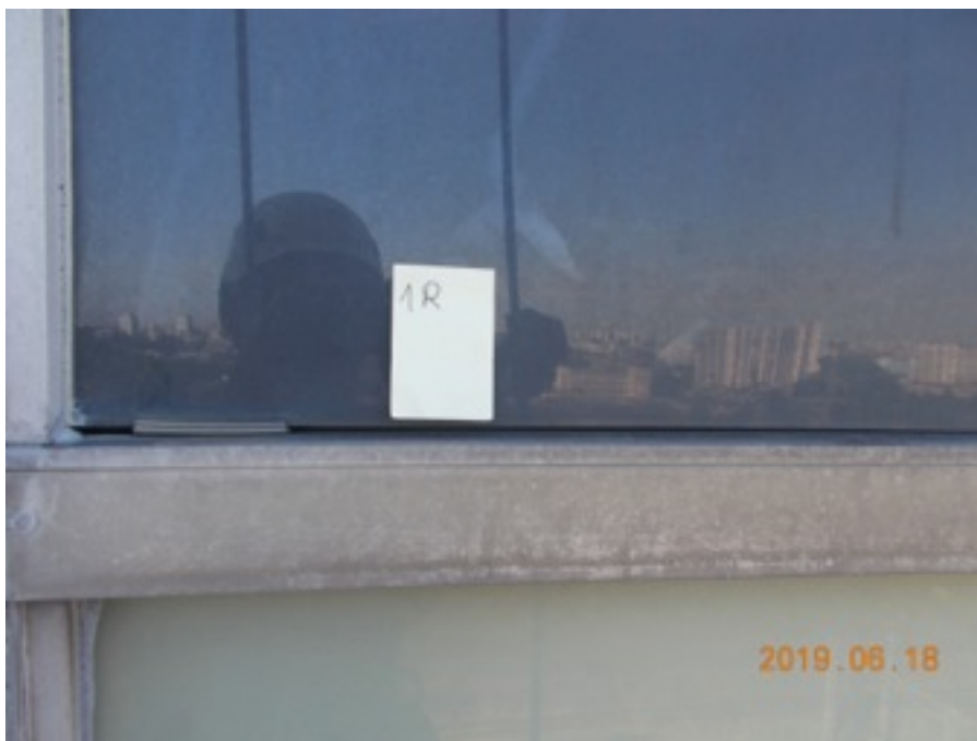
Zdjęcie Nr 63 - sposób podparcia szyby nieprzeźiernej na gumowych podkładkach jest charakterystyczny dla przeglądanej elewacji i wygląda na to, że zastosowano taki montaż w trakcie budowy budynku - VIII p.
