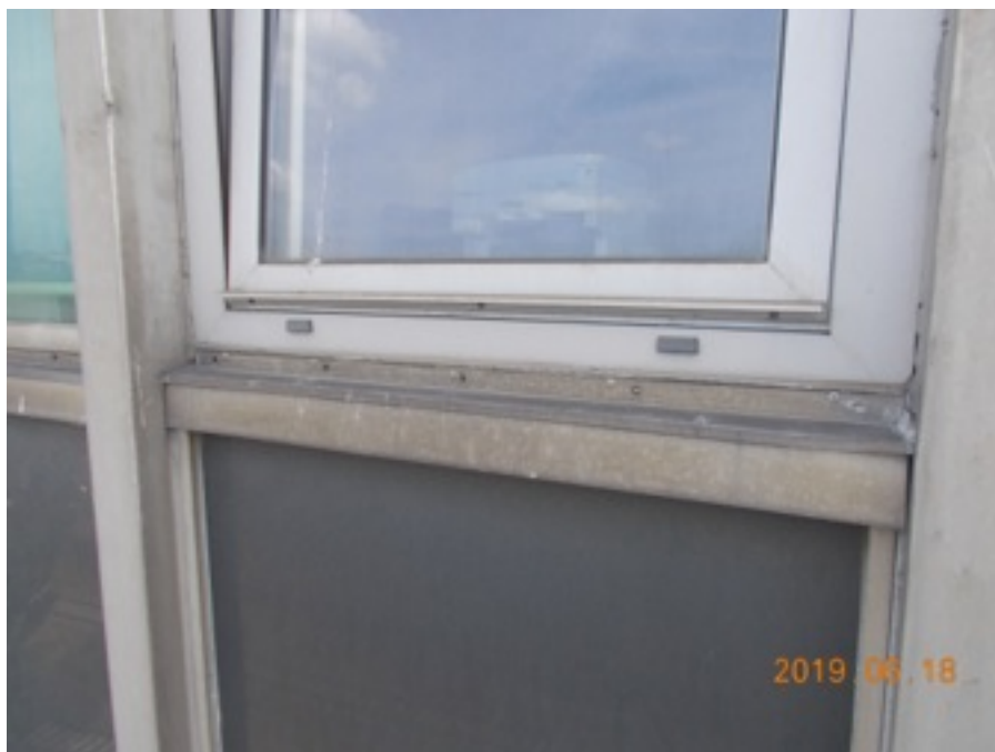
Zdjęcie Nr 116 - pozostawiono nie zaślepione otwory po nitach - V p.
