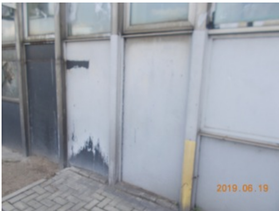
Zdjęcie Nr 163 - w miejsce szyb zamontowano maskownice z płyt - 0 p.
