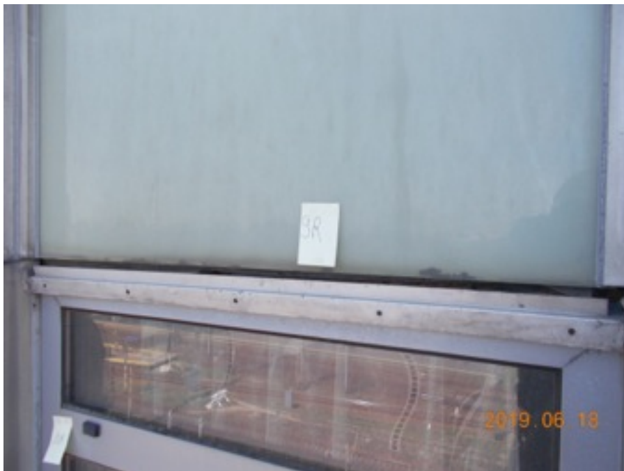
Zdjęcie Nr 76, 77, 78, 79, 80, 81 - brak podparcia szyby nieprzeźiernej, brak profilu podpierającego szybę, brak systemowych obróbek blacharskich zamykających fasadę, brak ciągłości fugi - VI p.
