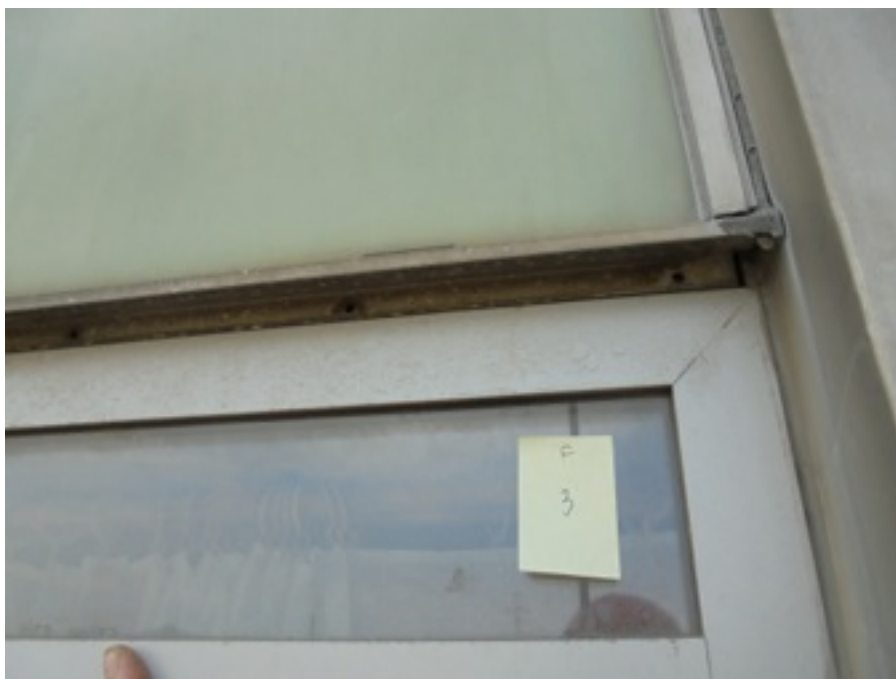
Zdjęcie Nr 45, 46, 47 - brak łączników w listwie fasadowej; listwa wspiera się na wkręcie przymocowanym do słupa fasady - VI p.
