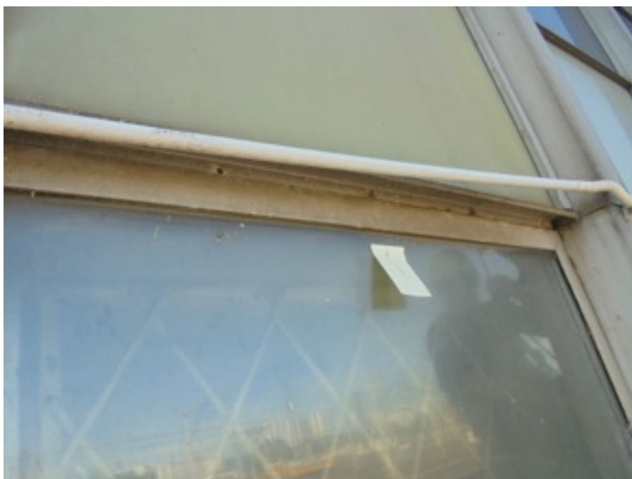
Zdjęcie Nr 2 - brak łączników w listwie fasadowej - 0 p.
