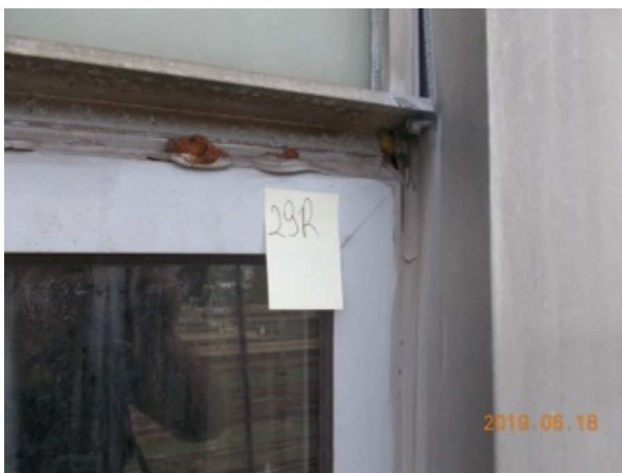
Zdjęcie Nr 116 - pozostawiono nie zaślepione otwory po nitach - V p.
