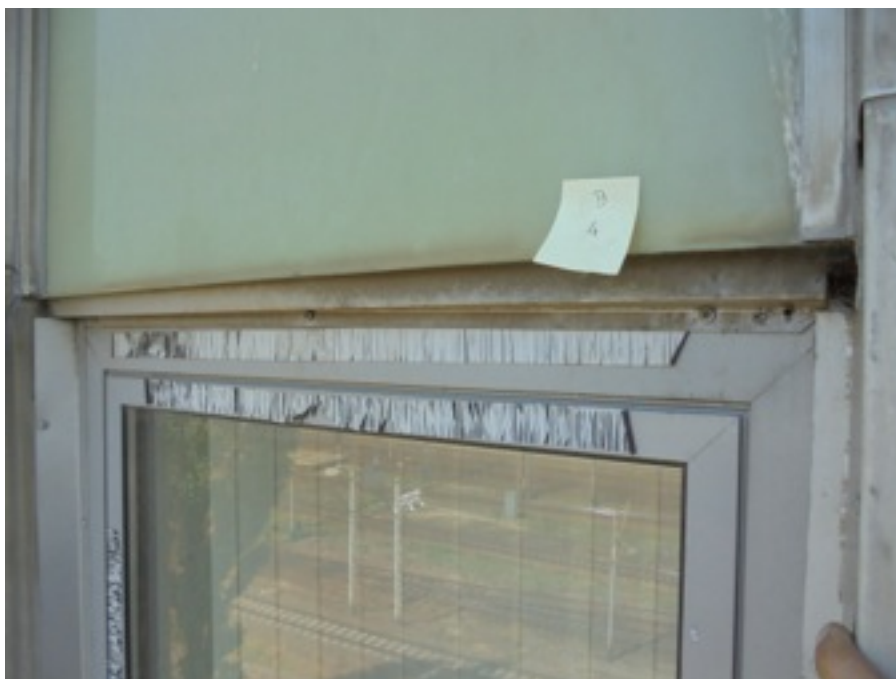
Zdjęcie Nr 11 - niesystemowe obróbki po wymianie okna; szyba nieprzezierna bez podparcia i mocowania dolnego poziomego, przyklejona do pionowych listew fasadowych - III p.
