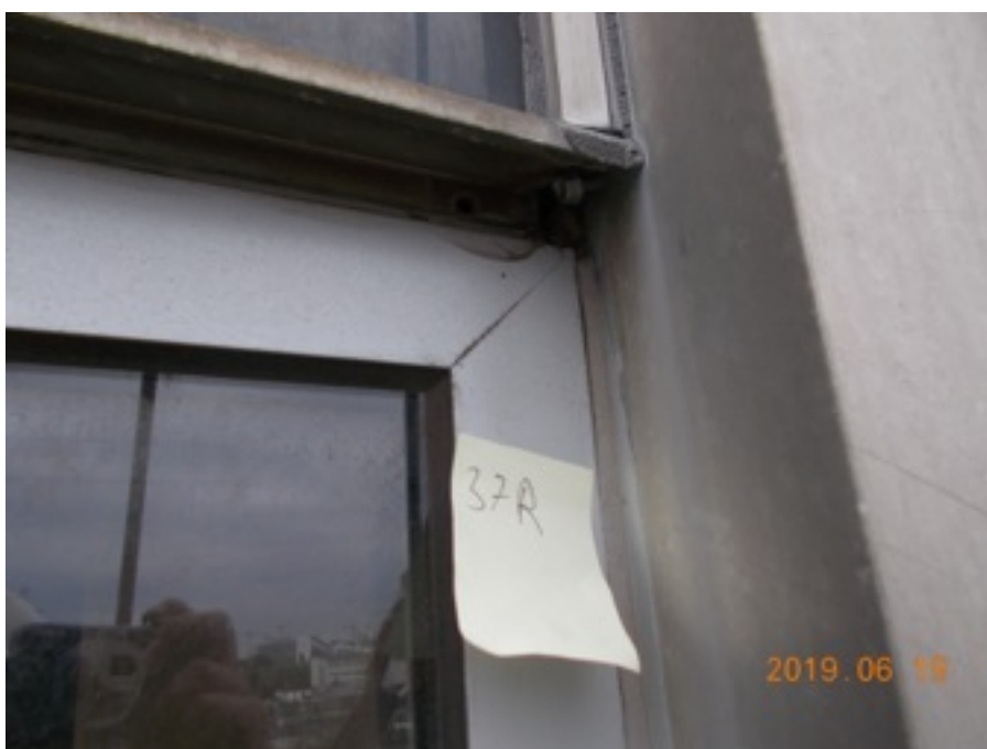
Zdjęcie Nr 128 - brak łączników w listwie fasadowej; listwa podpierająca szybę zablokowana wkrętem - VI p.
