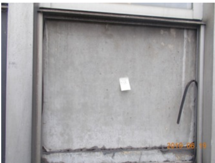
Zdjęcie Nr 143 - brak profilu podpierającego szybę nieprzezierną, brak systemowych obróbek blacharskich - I p.
