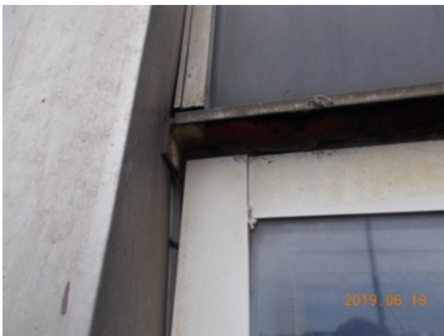
Zdjęcie Nr 142 - profil podpierający szybę nieprzezierną wsparty na kątowniku - I p.
