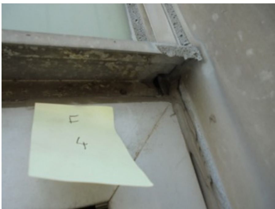
Zdjęcie Nr 45, 46, 47 - brak łączników w listwie fasadowej; listwa wspiera się na wkręcie przymocowanym do słupa fasady - VI p.
