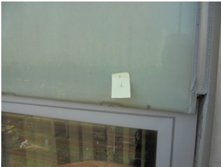
Zdjęcie Nr 43 - dyslokacja szyby nieprzeziernej - wysunięta z profili mocujących -VIII p.
