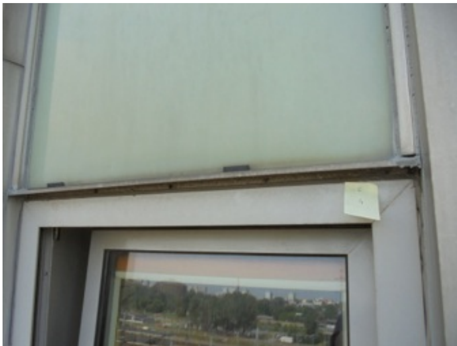
Zdjęcie Nr 48, 49 - brak łączników w listwie fasadowej; listwa wspiera się na klinie - V p.
