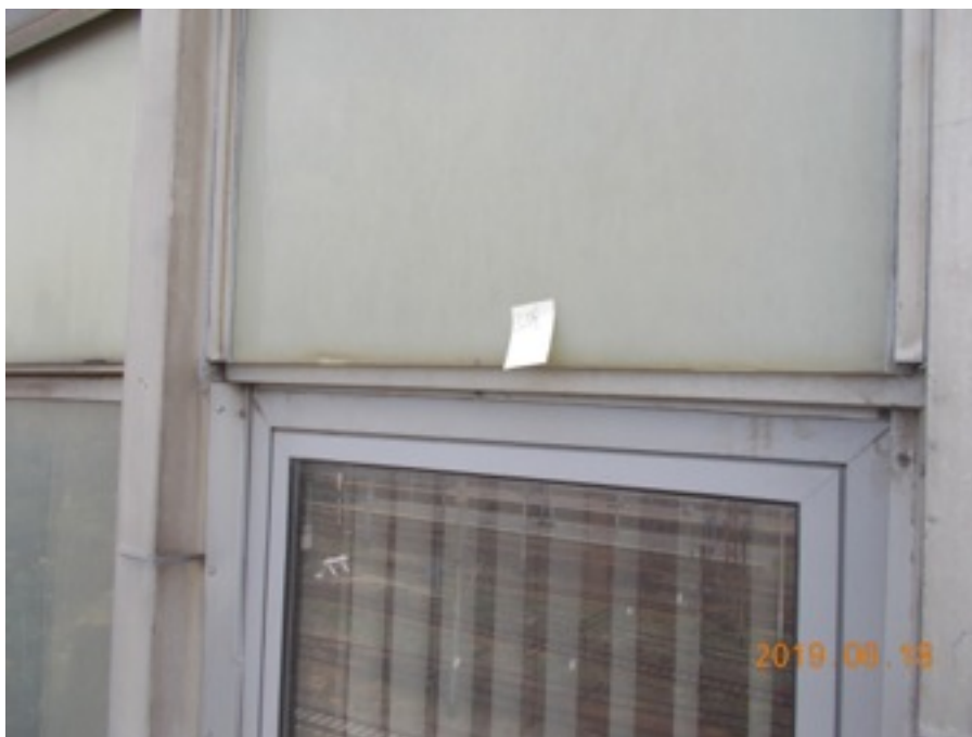
Zdjęcie Nr 120 - brak listwy podpierającej szybę nieprzezierną; szyba z prawej strony wysuwa się z profilu mocującego. - III p.
