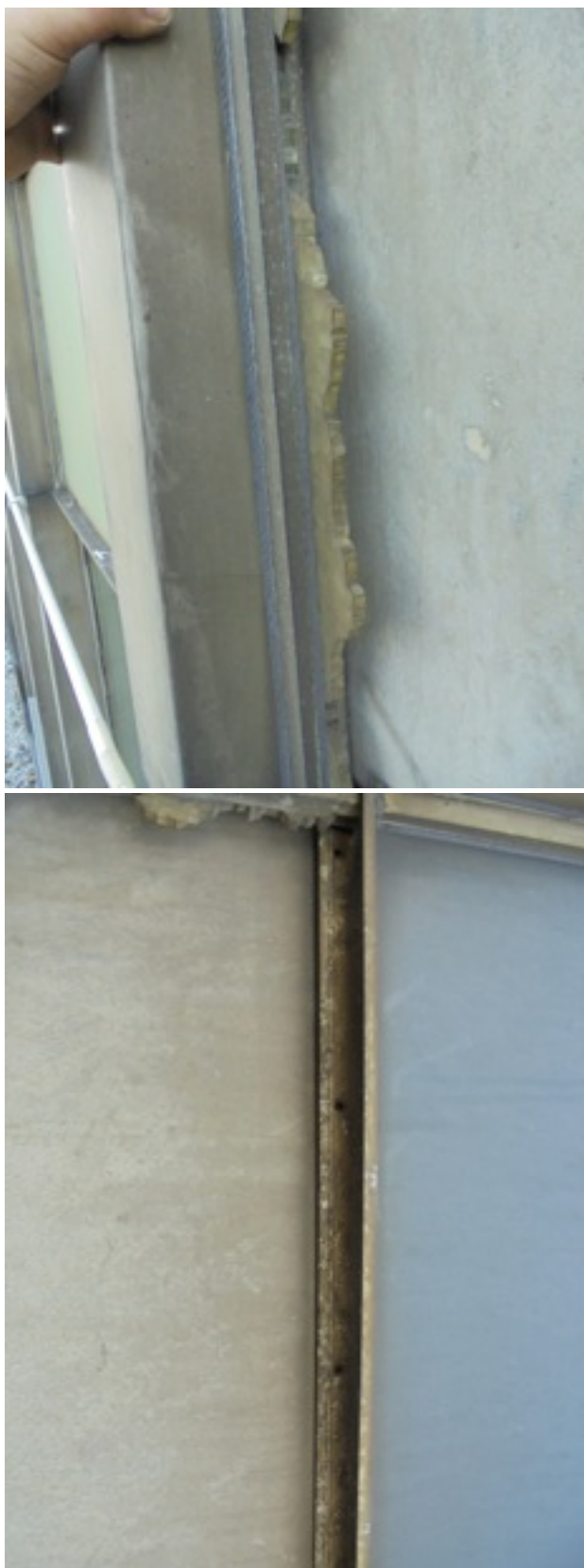
Zdjęcie Nr 58, 59, 60, 61, 62 - brak szyby, pozostałe w profilach fragmenty szkła świadczą, że została stłuczona - 0 p.
