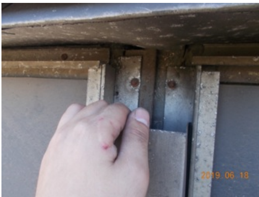
Zdjęcie Nr 72 - brak ciągłości maskownicy - II p.
