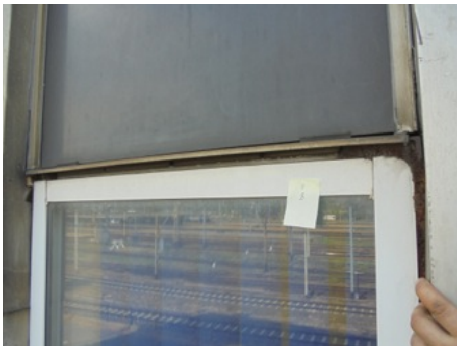
Zdjęcie Nr 54, 55 - brak łączników w listwie fasadowej; listwa podpierająca szybę wklejona na piankę montażową - I p.
