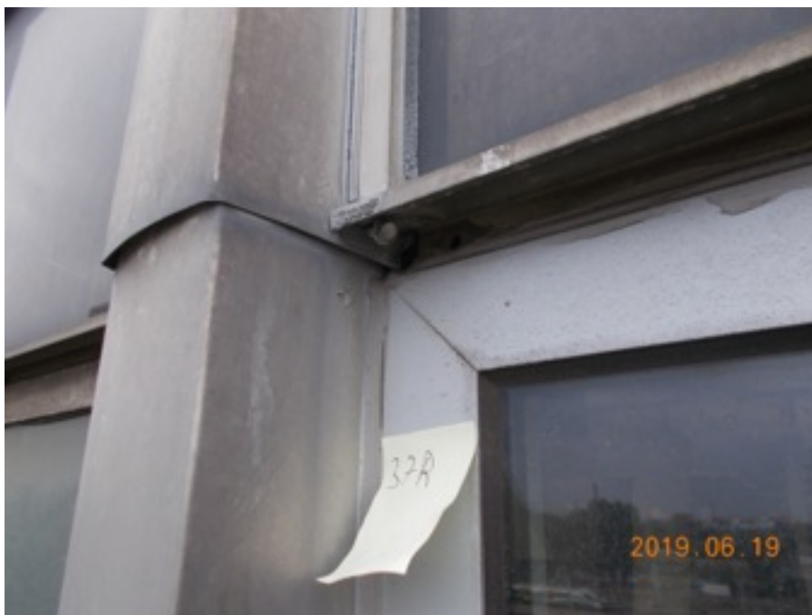
Zdjęcie Nr 129, 130 - brak łączników w listwie fasadowej; listwa podpierająca szybę zablokowana wkrętem - V p.
