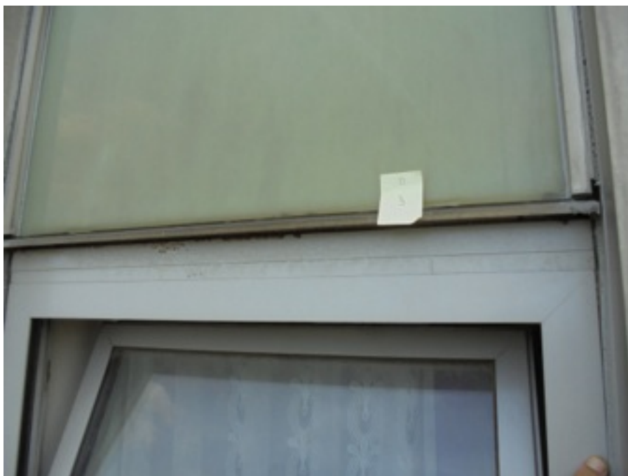
Zdjęcie Nr 32, 33 - brak łączników w listwie fasadowej; listwa wygląda na przyklejoną - Vlp.
