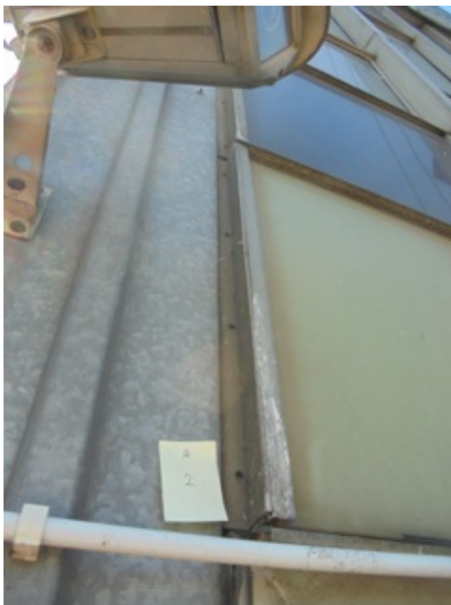
Zdjęcie Nr 2 - brak łączników w listwie fasadowej - 0 p.
