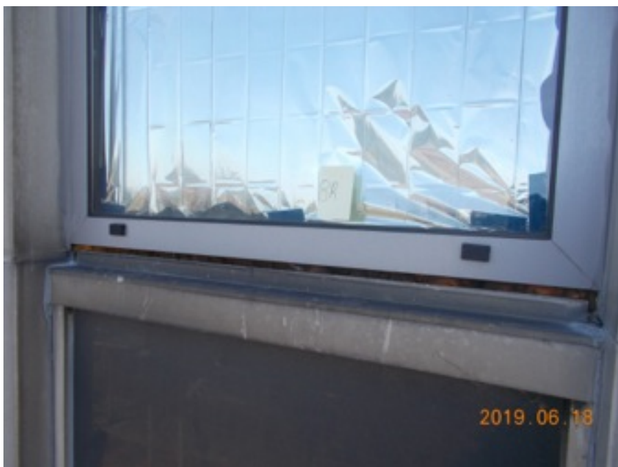
Zdjęcie Nr 76, 77, 78, 79, 80, 81 - brak podparcia szyby nieprzeźiernej, brak profilu podpierającego szybę, brak systemowych obróbek blacharskich zamykających fasadę, brak ciągłości fugi - VI p.
