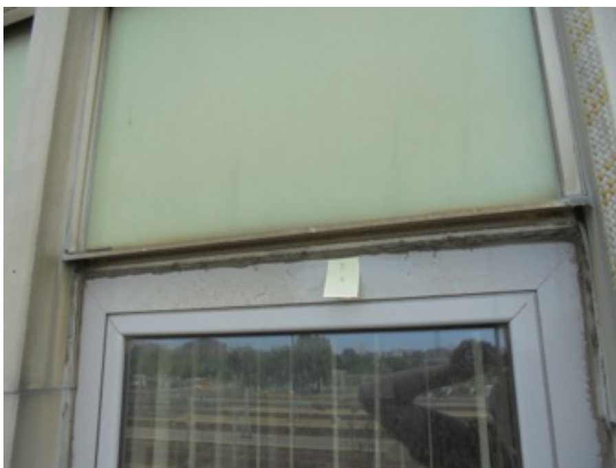
Zdjęcie Nr 32, 33 - brak łączników w listwie fasadowej; listwa wygląda na przyklejoną - Vlp.
