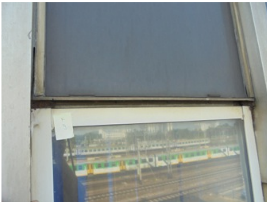
Zdjęcie Nr 56, 57 - brak łączników w listwie fasadowej; listwa podpierająca szybę wklejona na piankę montażową - I p.
