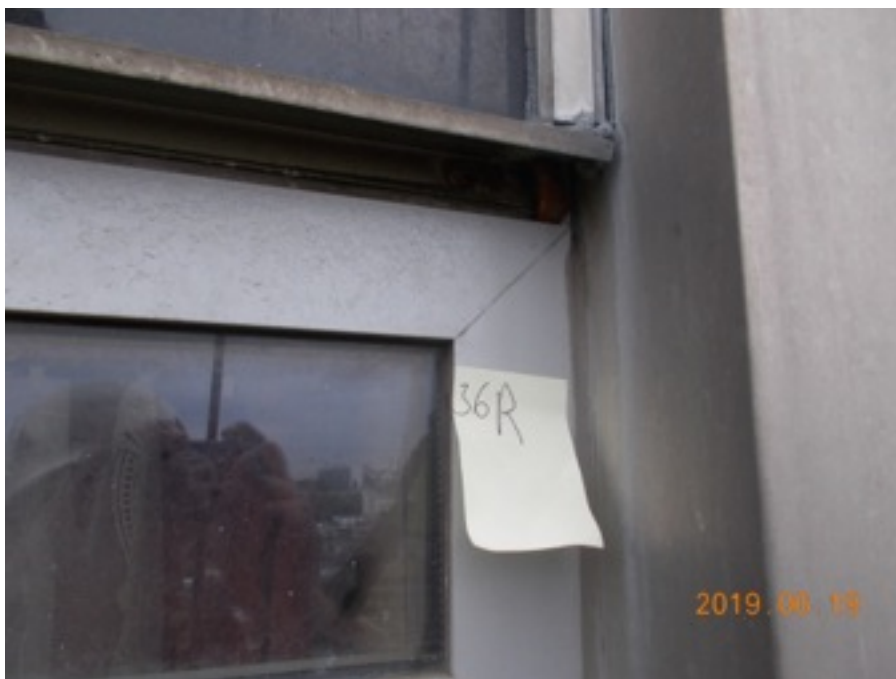
Zdjęcie Nr 128 - brak łączników w listwie fasadowej; listwa podpierająca szybę zablokowana wkrętem - VI p.
