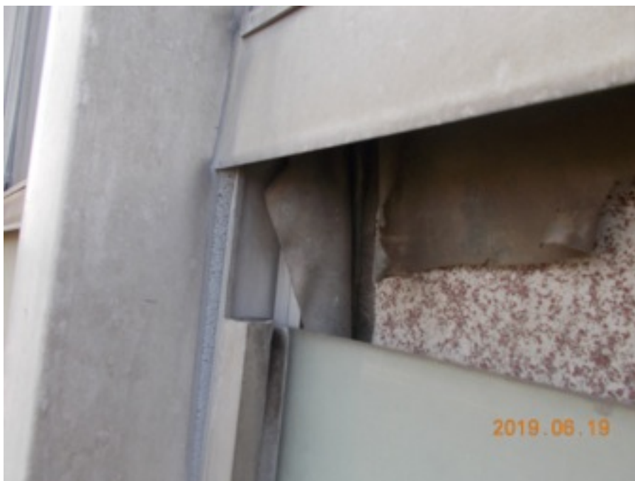
Zdjęcie Nr 151, 152, 153 - dyslokacja szyby nieprzeziernej wraz z listwami mocującymi - IV p.
