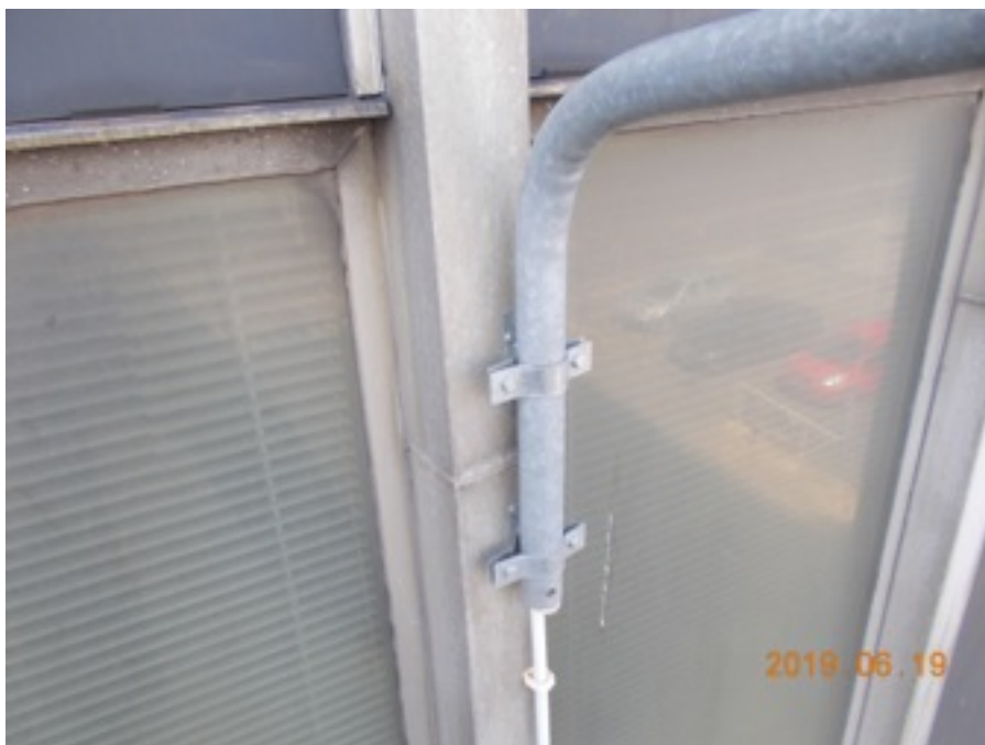
Zdjęcie Nr 159 - lampę przymocowano do maskownicy słupa fasady - I p.
