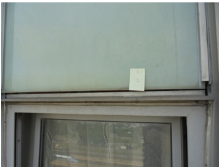
Zdjęcie Nr 44 - brak łączników w listwie fasadowej; listwa podpierająca szymbę wygląda na przyklejoną - VII p.
