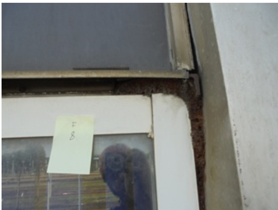
Zdjęcie Nr 51, 52, 53 - brak łączników w listwie fasadowej; listwa wspiera się na wkręcie przymocowanym do słupa fasady; brak systemowych obróbek po wymianie okna; uszkodzony okapnik w skrzydle okiennym - III p.
