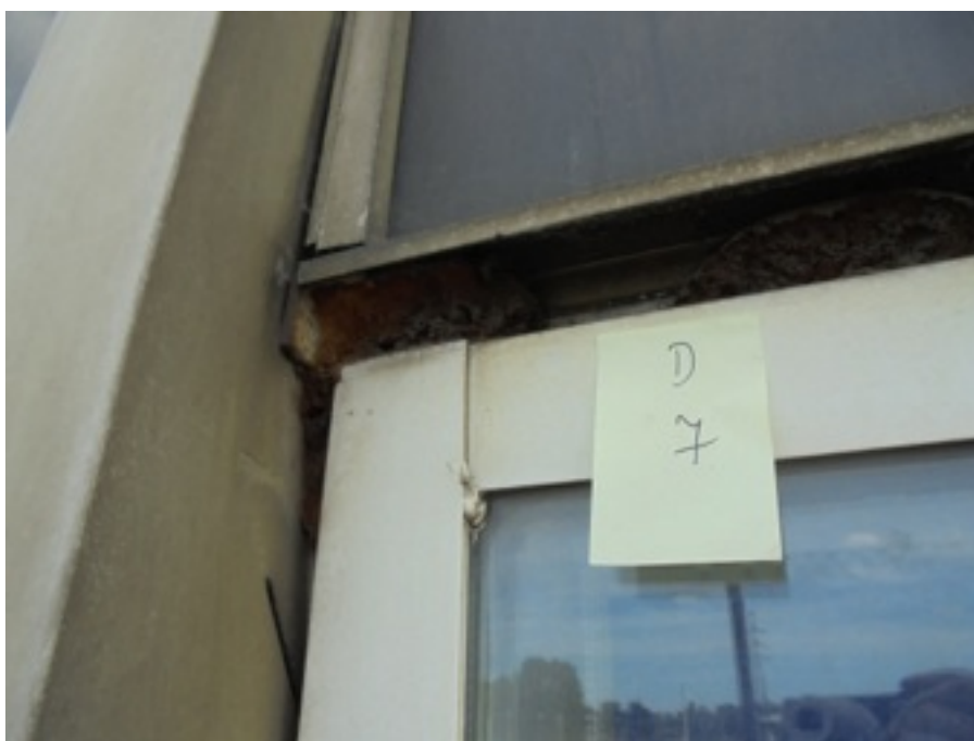
Zdjęcie Nr 34, 35 - brak łączników w listwie fasadowej; listwa wygląda na przyklejoną - IIIp.
